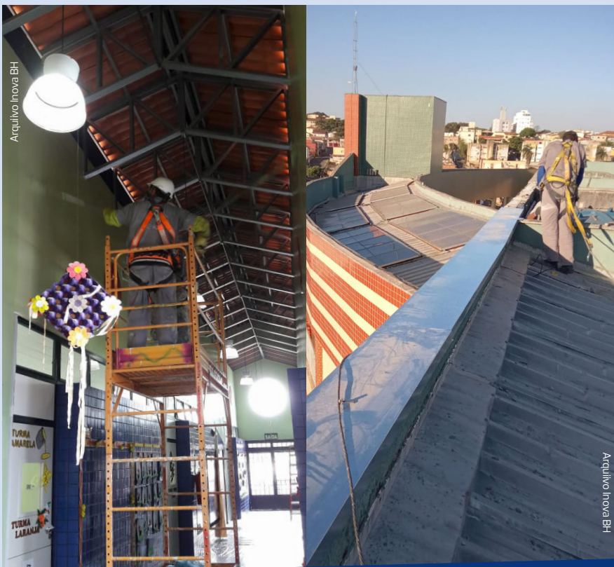
Seja pintura ou manutenção no telhado, nada escapa dos olhos atentos da nossa equipe de manutenção
