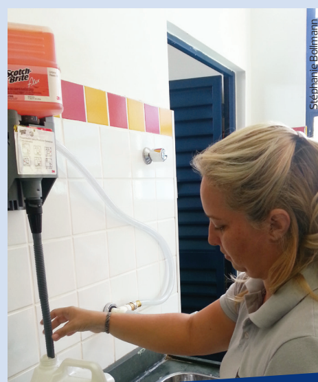
Uma das facilidades dos novos equipamentos é o dispensador de produtos químicos concentrados. Basta que a Auxiliar Administrativa encaixe o produto no equipamento para que a diluição seja feita. O próprio equipamento já mistura a quantidade adequada de água e o produto sai no galão pronto para o uso
