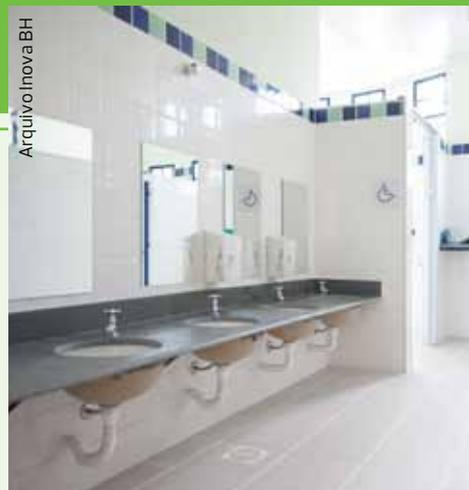
**As torneiras da escola possuem válvulas que misturam ar à água. Apesar da diminuição do volume de água, por causa do ar, a sensação de vazão é a mesma e não compromete a qualidade da lavagem**
