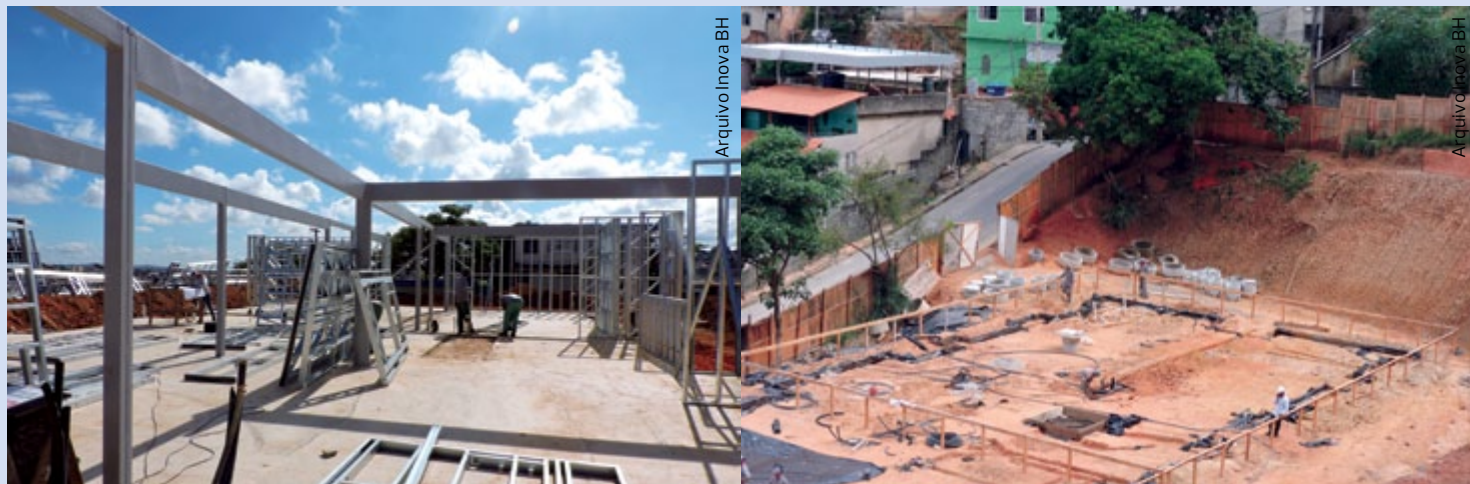
Durante as reuniões, apresentamos à comunidade as obras que estão sendo construídas, informando suas etapas e previsões. À esquerda está a obra da Umei Marfim e à direita a preparação do terreno da Umei Nova York
