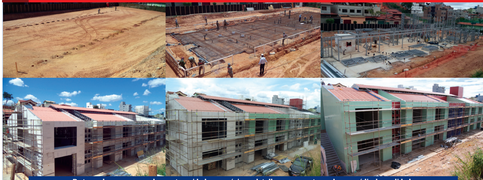
Da terraplanagem ao acabamento: cuidado nos mínimos detalhes para a entrega de um prédio de qualidade
